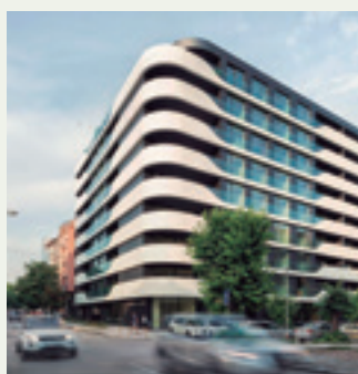
Különleges lakóépület Bulgáriában, hatékony épületgépészeti megoldással. Aquarea
